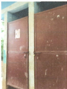
Foto 1: Mantenimiento a puerta metálica existente retiro de óxido, suciedad y pintura deteriorada; incluye cepillado, lijado y aplicación de pintura dos de módulo de aulas y cuatro de sanitarios
