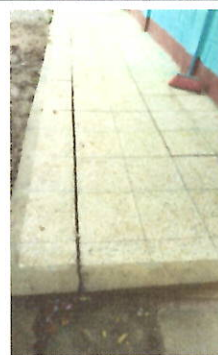
Foto 6: Sustitución de piso de granito, por piso de granito, incluyendo preparación de superficie y nivelación, en área de baños y corredor
