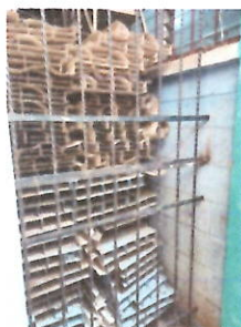
Foto 3: Sustitución de barandales metálicos, incluyendo fijaciones, pintura y soldaduras
