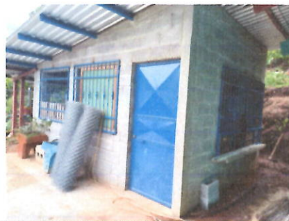
Foto 2: Preparación de la superficie y aplicación de pintura a dos manos, en paredes interiores y exteriores del establecimiento en área de cocina y sanitarios
