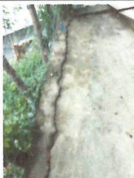
Foto 5: Reparación de losa de concreto para patios, al contorno del módulo de aula, considerando preparación de terreno, armado, nivelación y acabado rustico.
